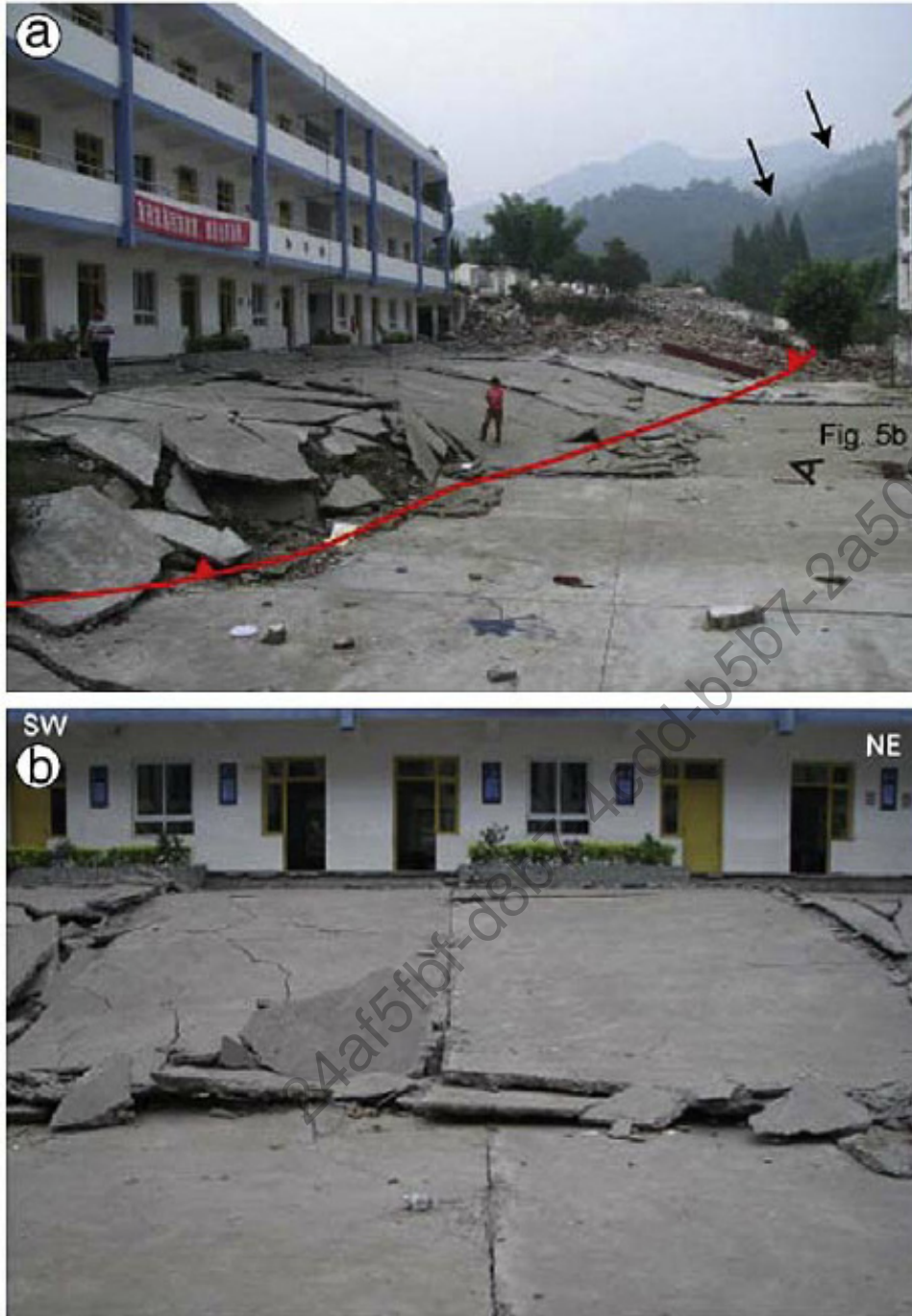
شکل ۷. زون گسیختگی سطحی روی گسل پنگوان در شهر بایلوچین در زلزله ونچوان ۲۰۰۸ [۳۰]
